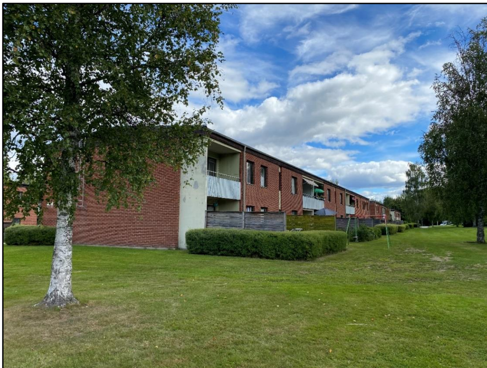
Nuvarande bostadshusområde Krokfors, Kopparberg
